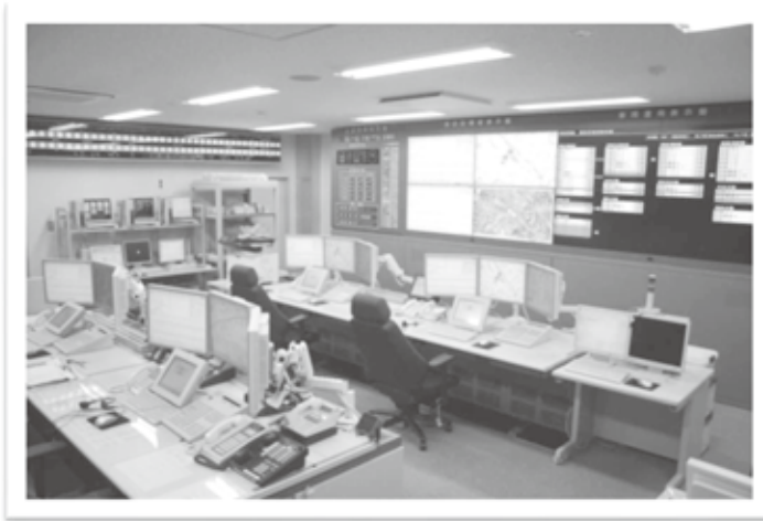
高機能消防指令システム
